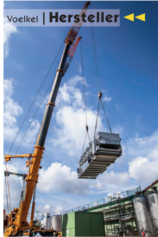
Zwei 500-Tonnen-Autokrane bringen Voelkels neue Flaschenwaschmaschine in Position. 22.000 Flaschen pro Stunde kann ‚Niedersachsens größte Spülmaschine‘ in den Pfandkreislauf zurückführen (re.). Große 0,75-Liter- und kleine 0,2-Liter-Mehrwegflaschen ergänzen mittlerweile die beliebten Ingwer-Demeter-Shots (unten).
